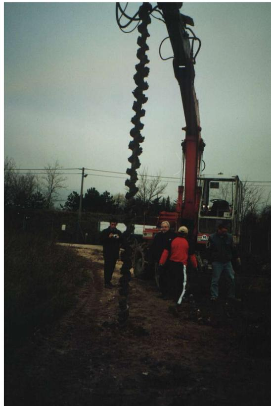
*Esecuzione di indagine geotecnica mediante trivellazione -
