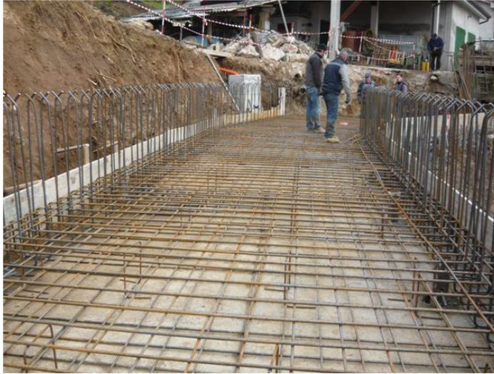
*Progetto per strada di collegamento in pendio realizzata mediante scatolare sottofondato a Galzignano Terme (PD)*
